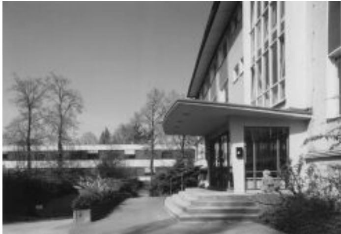
Blick auf den Eingangsbereich und den Neubau
