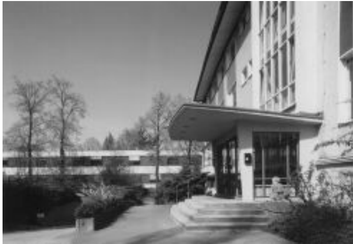
Blick auf den Eingangsbereich und den Neubau
