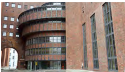
Schaltwerk Berlin-Mitte http://www.schaltwerk-berlin.com/
